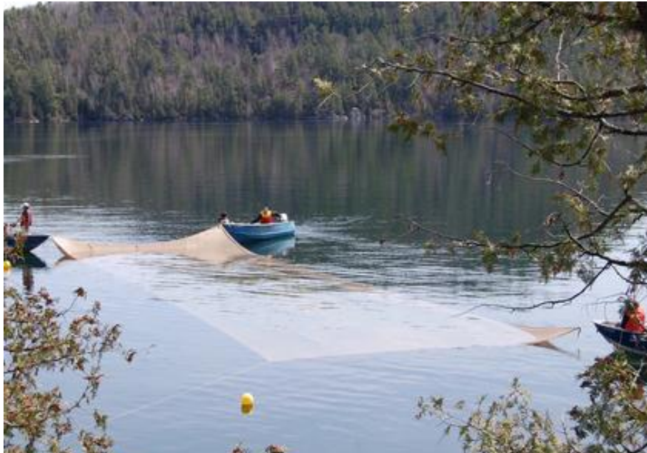
Figure 3 : Installation de toiles de jute au lac Gauvreau (Enviro Lac Gauvreau, 2025).
