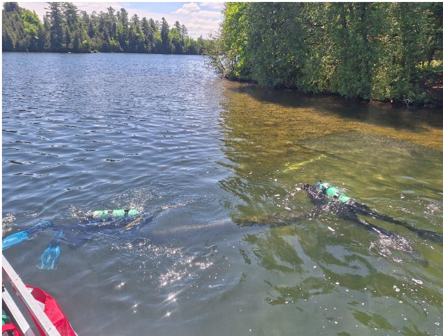
Figure 10 : Installations d'une toile synthétique par deux plongeurs.
