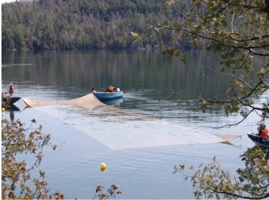
Figure3 : Installation of jute fabric at Lake Gauvreau (Enviro Lac Gauvreau, 2025).
